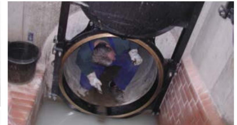
**KÖSTER-Spindelschieber DN 1000 aus Gusseisen mit metallischen Dichtflächen aus Bronze**
