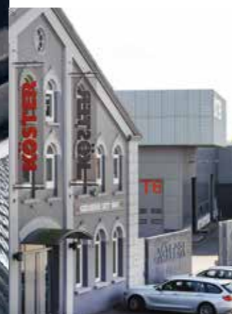
Photo du haut: Le siège de la société KÖSTER - La maison de comptoir avec vue sur le nouvel atelier de fonderie
