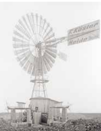
Centrale électrique éolienne pour générer du courant en stationnaire - Une innovation signée KÖSTER à l'ère de l'industrialisation
