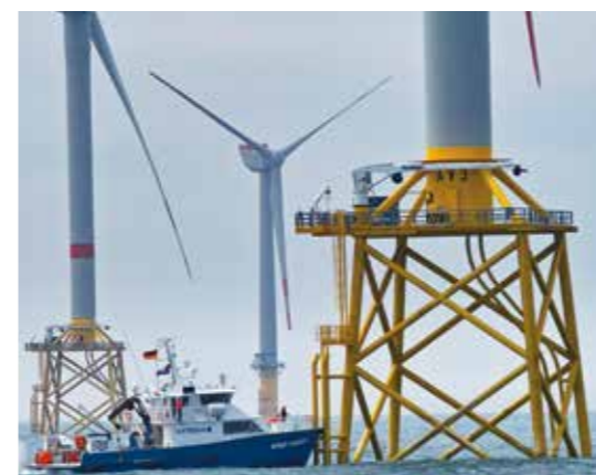
2012 Parc éolien en offshore - ouest de l'île de Borkum (Allemagne) Treuils manuel en acier inox
