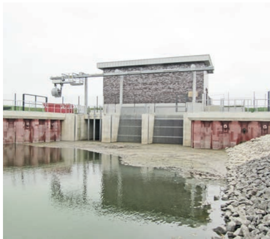
Schöpfwerk Luneplate VP 900 Vertikale Propellerpumpe 2.600 l/s 3,6m 160 kW
