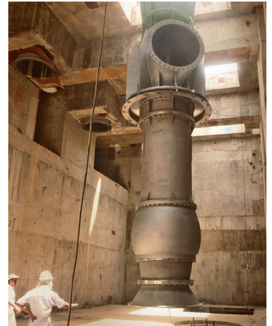
Dockpumpe am Persischen Golf VKP 1400 Vertikale Halbaxialpumpe 6.670 l/s 20m 1.800 kW
