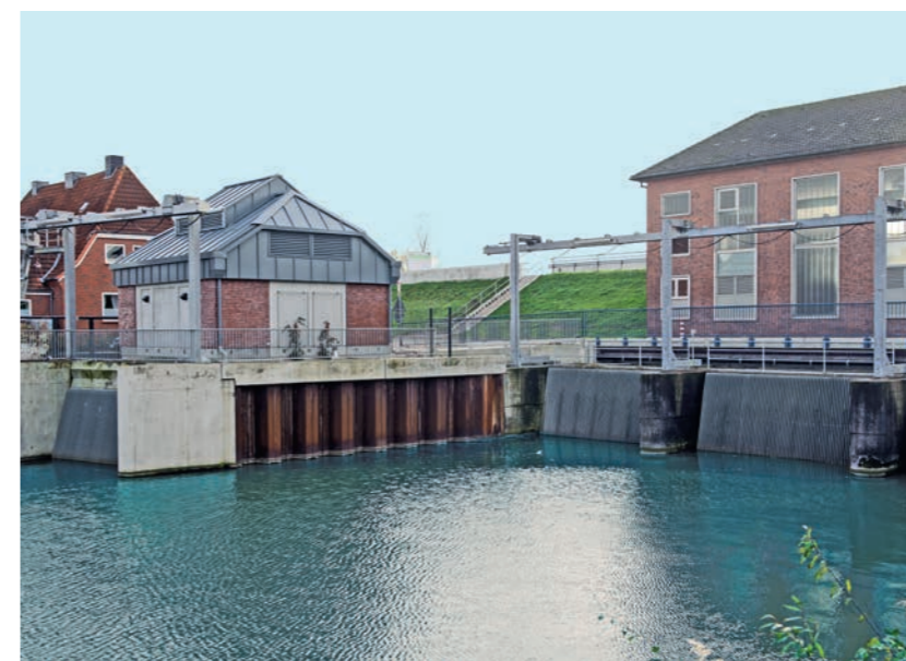
Schöpfwerk Brunsbüttel-Nord VPH 1400 Vertikale Propellerpumpe, hängend 6.000 l/s 6,0m 560 kW
