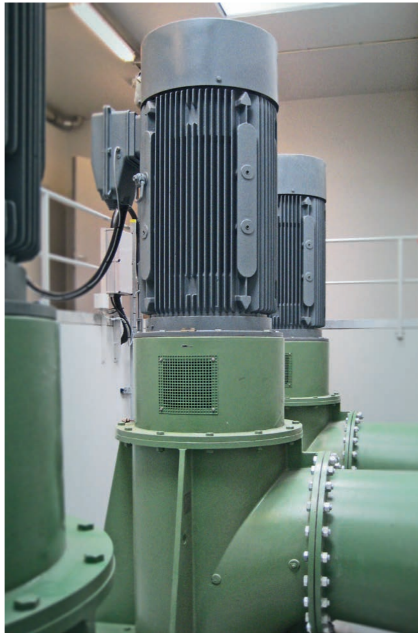
Pumpwerk Avedore Holme (Kopenhagen, Dänemark) VPH 800 Vertikale Propellerpumpe, hängend 1.700 l/s 8,0m 200 kW
