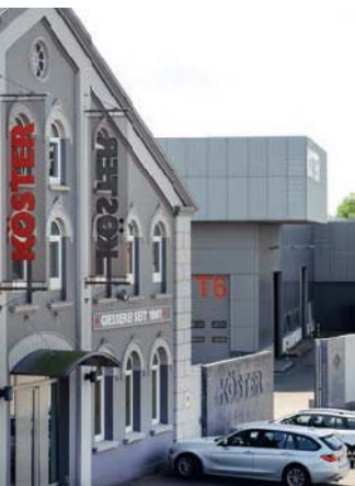
Felső kép: A KÖSTER cég székhelye - az irodaház mögött az új öntöde látható
