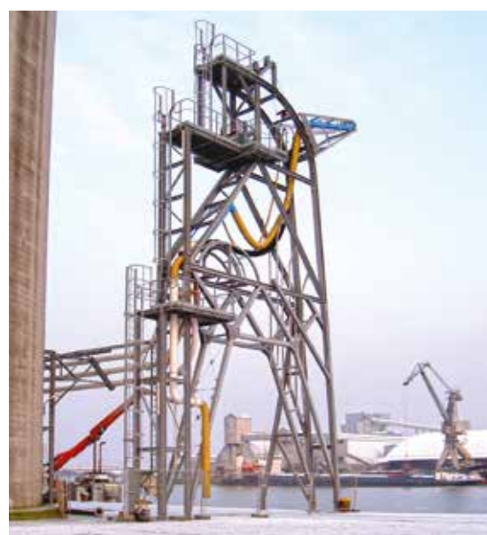
2004 Port d'Anvers (Belgique) Équipement de chargement des bateaux
