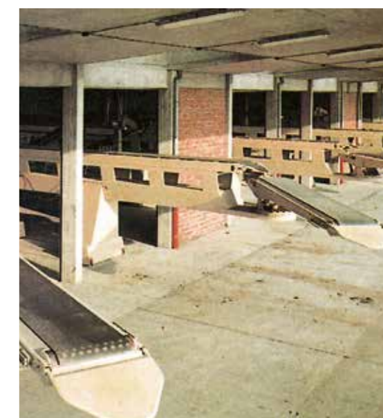
1970 Terminaux de chargement avec huit installations de chargement
