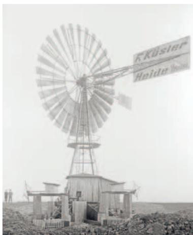
Windkraftanlage zur stationären Stromerzeugung - KÖSTER-Innovation im Zeitalter der Industrialisierung
